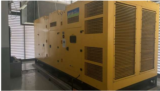
ผ 3- 32 เครื่องสำรองไฟฟ้าและไฟสำรองฉุกเฉินของโครงการ
