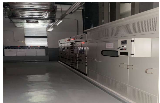
ผ 3- 48 รูปห้อง MDB ติดตั้งหม้อแปลงไฟฟ้า
