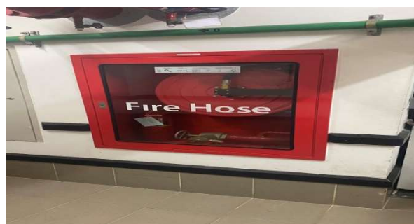
ผ 3- 35 ติดตั้งตู้ FCH พร้อมอุปกรณ์ภายในตู้ มีถังดับเพลิงแบบ Dry Chemical Extinguisher
