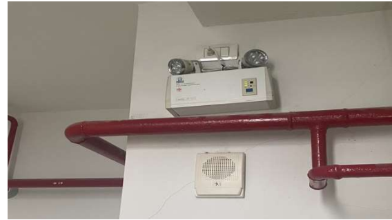
ผ 3- 32 เครื่องสำรองไฟฟ้าและไฟสำรองฉุกเฉินของโครงการ
