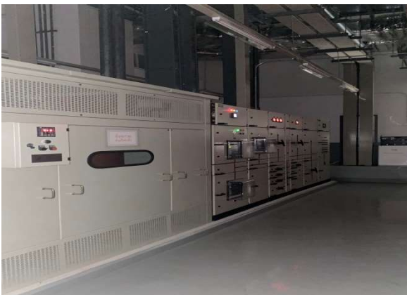
ผ 3- 48 รูปห้อง MDB ติดตั้งหม้อแปลงไฟฟ้า
